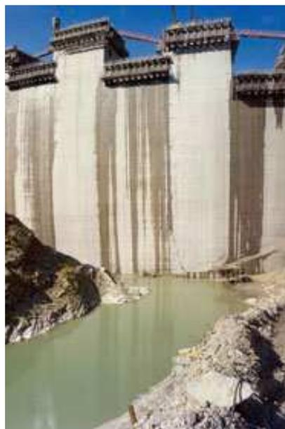
La struttura è radialmente suddivisa in 27 conci (Figura 3.4) separati da giunti costituiti da superfici pressoché verticali. Sia entro il pulvino che entro il corpo della diga sono stati predisposti cunicoli dimensionati in modo da consentire la realizzazione di tutte le opere di impermeabilizzazione e sutura dei giunti ed assicurare altresì il completo drenaggio delle acque di infiltrazione, scaricabili poi, senza alcun sollevamento, a valle dello sbarramento.
