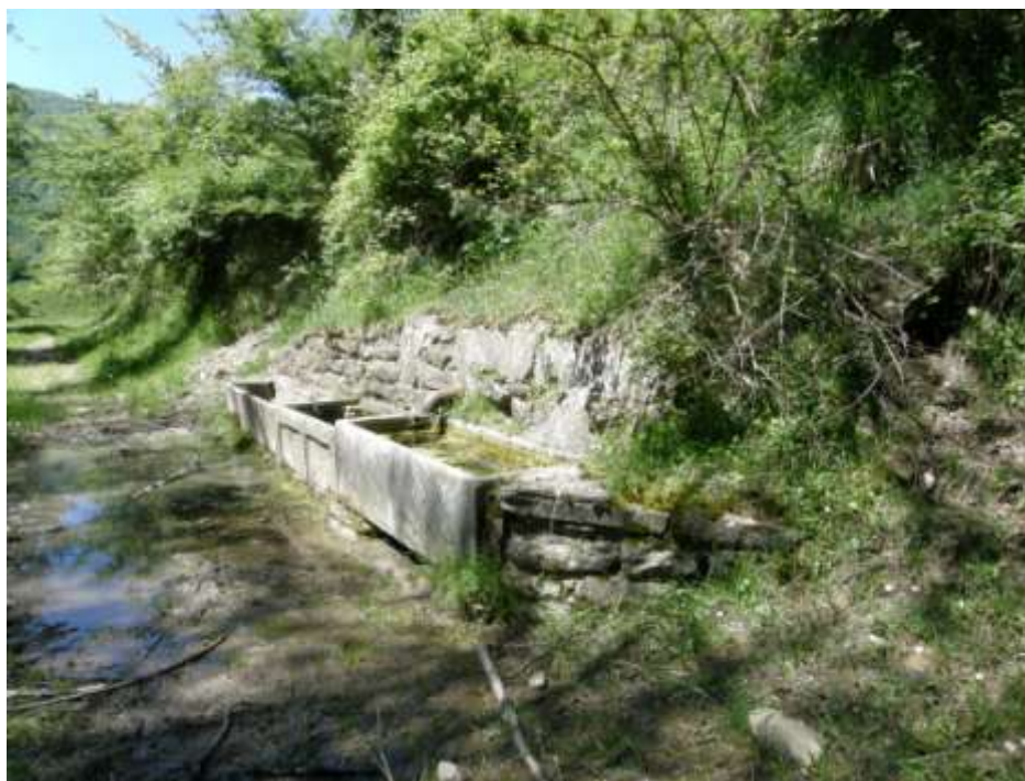
Figura 12 – Progetto “Recupero di habitat di prateria e realizzazione / manutenzione di strutture per piccoli anfibi”; Manutenzione straordinaria e miglioramento funzionale abbeveratoio loc. Pozzacchere
