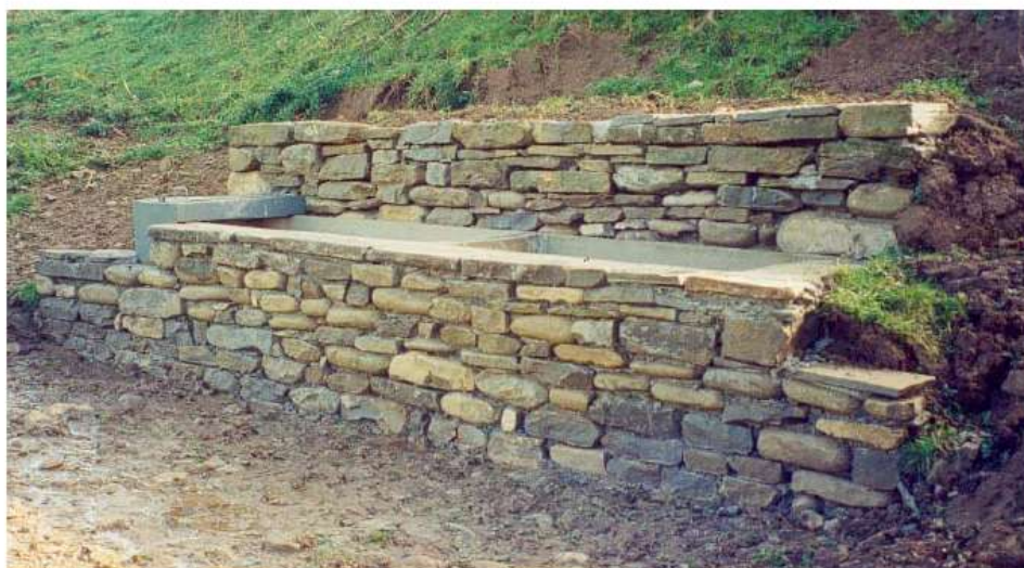
Figura 7 – Progetto “Recupero di habitat di prateria e realizzazione / manutenzione di strutture per piccoli anfibi”; Modello di riferimento per la realizzazione degli abbeveratoi (Fonte: Quaderno Opere in Agricoltura, del Parco Nazionale delle Foreste Casentinesi, Monte Falterona e Campigna)
