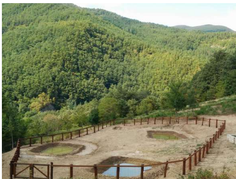
Fig. 9 - Sito Stradelli durante lo svolgimento dei lavori (foto tratta da Piazzini, 2018).
