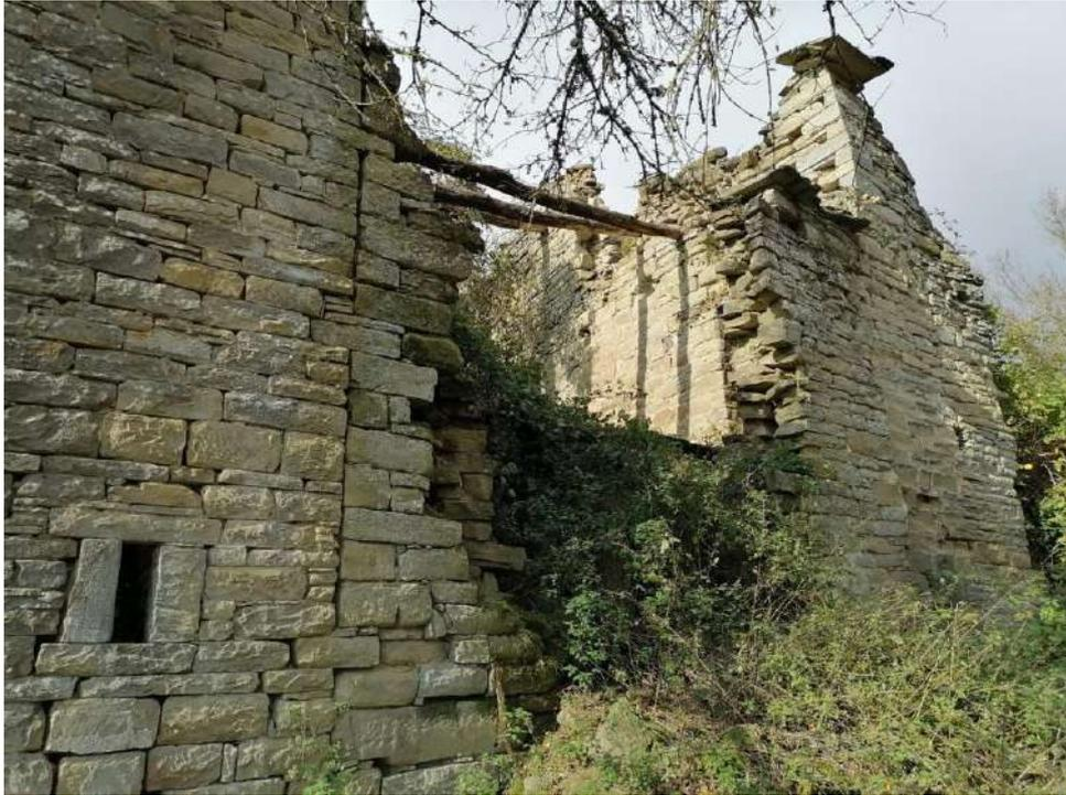
*Figura 100. Particolare della muratura del PP 1 del CF 1 e del crollo di CF 2, si noti lo spessore del muro costruito a sacco.*
