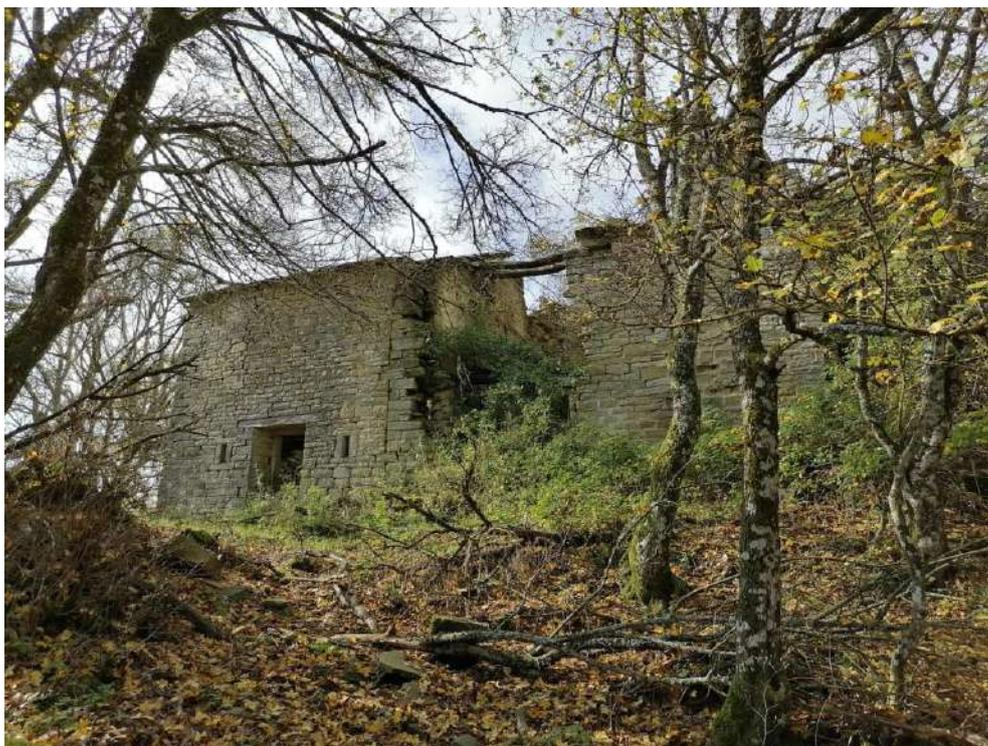
*Figura 98. Veduta del complesso architettonico di Casa Lastra dal lato sud. Al centro il crollo del PP 1 del CF 2. Mentre a sx il PP 1 del CF 1 con l'apertura centrale con architrave in legno e le due piccole aperture laterali.*
