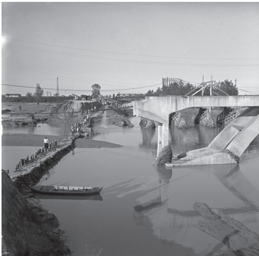
Fig. 3 – ARCHIVIO FOTOGRAFICO DI PIETRO ZANGHERI, Santa Sofia, Parco Nazionale delle Foreste Casentinesi, Monte Falterona, Campigna. Savio (bassa pianura ravennate): effetti della piena del fiume, con un ponte crollato e lavori di ripristino in corso. Immagine datata 4 giugno 1939 (negativo n. 1094).
