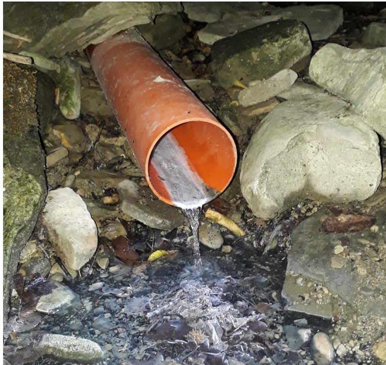
Figura 8. Scarico trovato nel sito di Villa. Da notare la patina bianca presente sia nel tubo che sul fondo del torrente.
