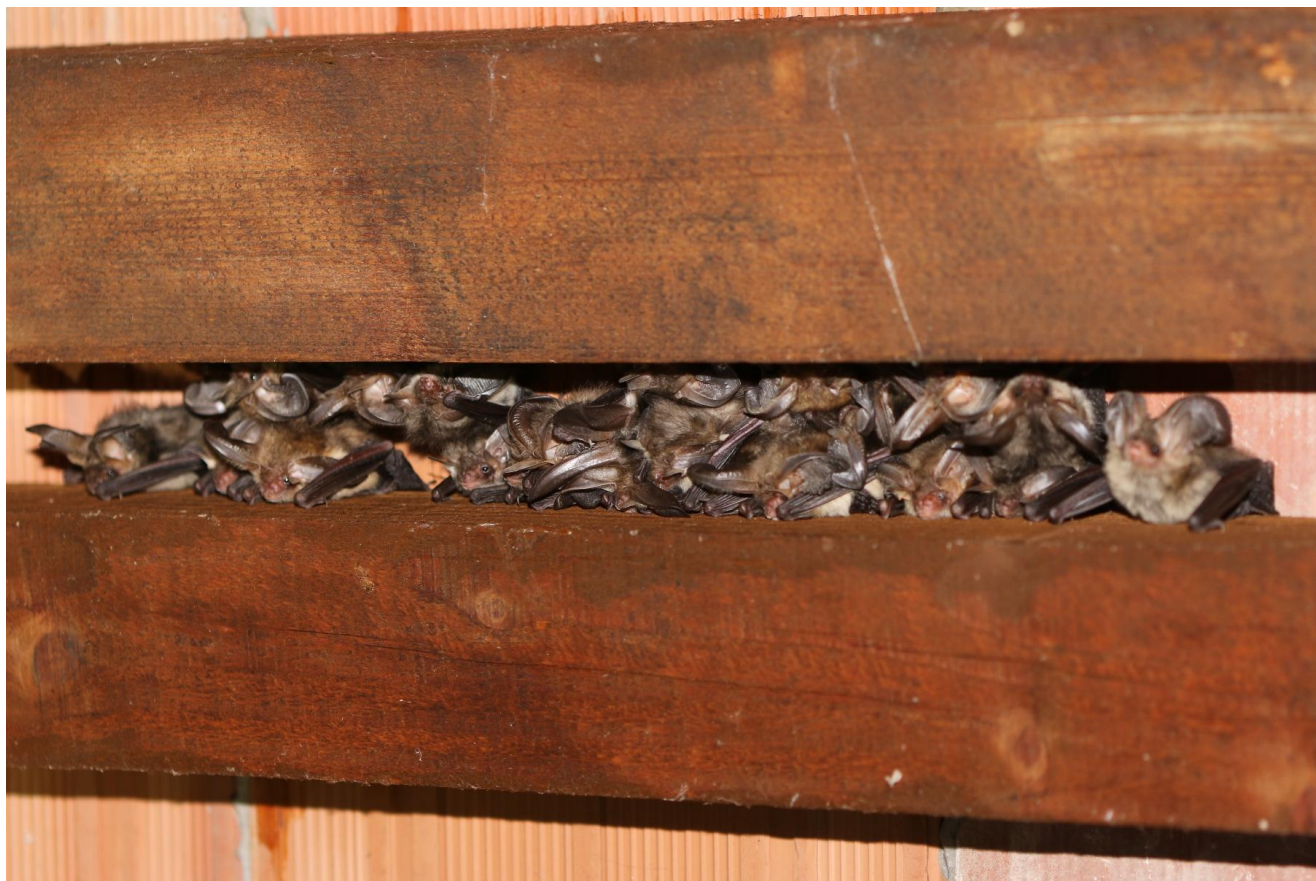
Figura n. 19 – Parte della nursery di P. auritus , nell'edificio (Sito n. 23)
